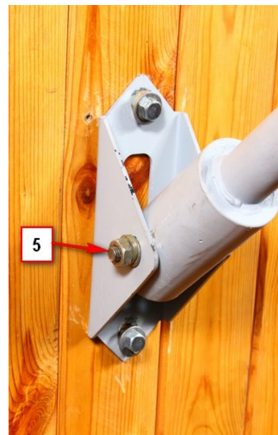
Труба закрепляется в пятке
