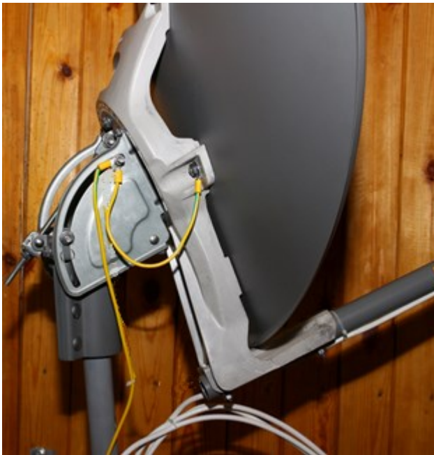
Рисунок 37. Крепление проводников заземления на антенне 0.74м
