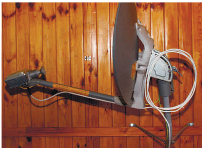
Рисунок 31 – Прокладка коаксиального кабеля
