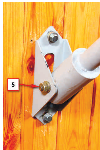
Труба закрепляется в пятке
