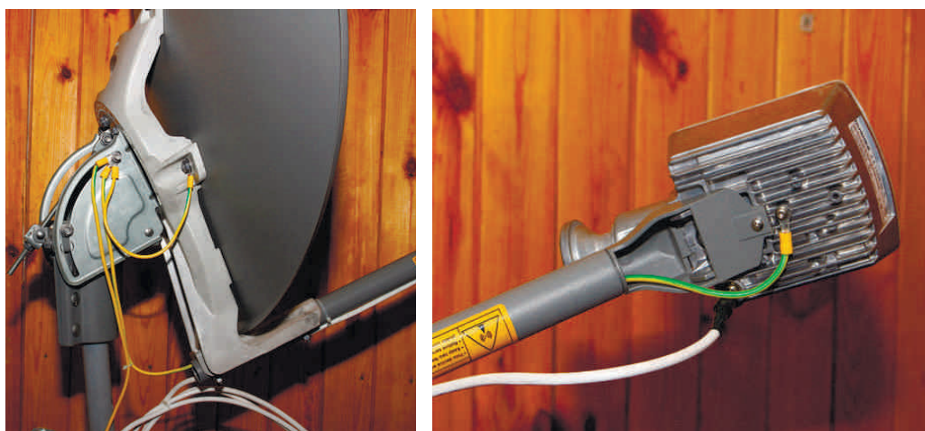
Рисунок 29 – Крепление проводников заземления на антенне 0,74м
